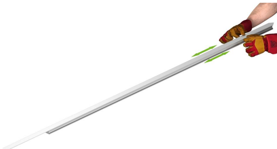
Rys. 5.28: Zaciskanie taśmy osłonowej na długości ok. 3 cm
